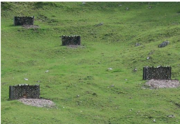
Abb. 32: Stirnholzstapel als Kugelfang, militärischer Schiessplatz Guldental, SO. Aus [12].
