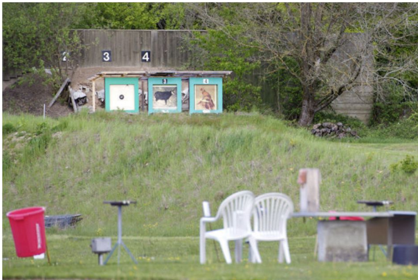
Abb. 22: Jagdschiessanlage Bergfeld, Wohlen bei Bern, [7].
