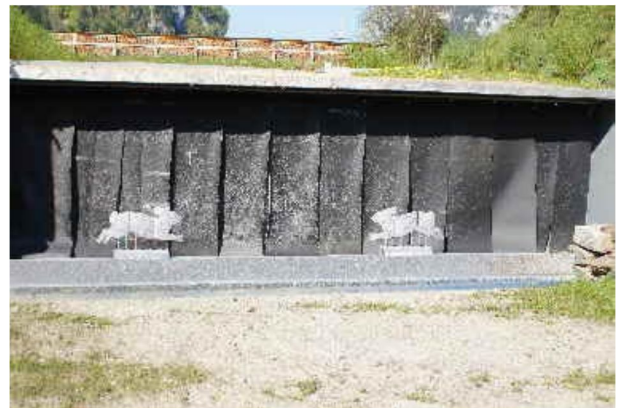
Abb. 27: Betonierter Kugelfangkasten hinter Kippsegment-Anlage mit Tierfiguren, [17].
