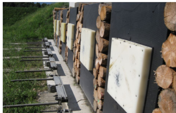
Abb. 31: 100m Jagdschiessanlage Rossboden, Chur, KKF hinter der Scheibentransportanlage: Frontplatte mit Verstärkungen, Foto magma AG, 27.8.2009.
