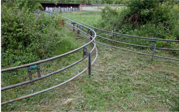
Abb. 28: Jagdschiessanlage Au, Embrach, Scheibentransportanlage Keiler, [30].
