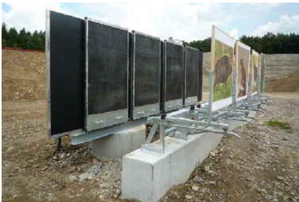
Abb. 26: Kugelfangkästen für 100m bis 150m Jagdschiessanlagen, [17].
