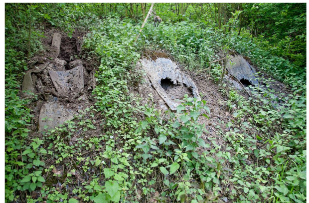
Abb. 20: Jagdschiessanlage Au, Embrach, Kugelfang Gämse, [30].
