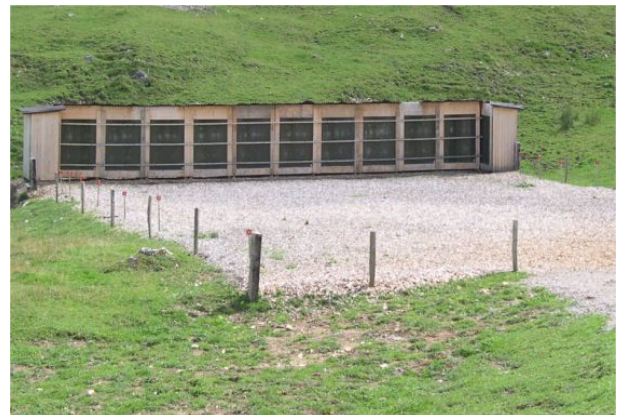
Abb. 33: Überdachter Holzverschlag mit Holzschnitzelfüllung auf einem Kurzstanz-Ausbildungsplatz, militärischer Schiessplatz Guldental, SO. Aus [12].
