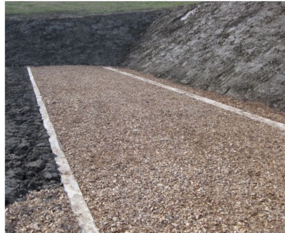
Abb. 36: Mehrzweckschiessanlage MZA 31, Reppischtal: abgedichtete Fläche über dem Kiesspeicher, rechts neues Kugelfangmaterial über der Abdichtung. Foto magma AG, 2.3.2011, aus [21].
